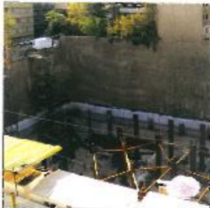
شکل ۲- تصویری از دیواره‌های میخ کوبی شده و مهارگذاری شده همراه با پروفل‌های دول
