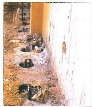
نصب پروفیل ها و بتن ریزی
