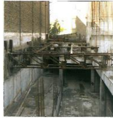
(ب) نمونه‌ای از مهار متقابل در گودبرداری
