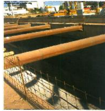
(الف) نمونه‌ای از مهار متقابل در کمانال‌ها
